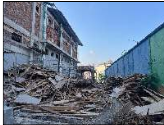
Gambar 4. Waste Material Bekisting pada Blok Hunian Maksimum
