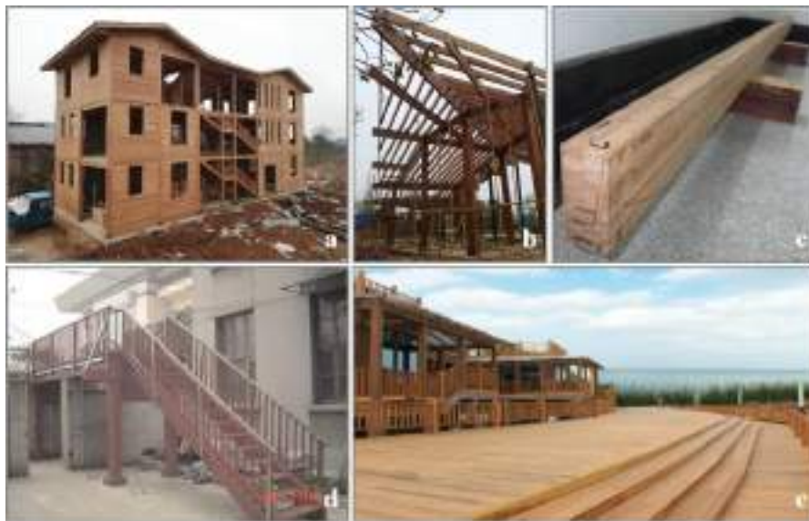
Gambar 3. Aplikasi produk bambu rekayasa a) bangunan bertingkat, b) rangka struktur, c) elemen balok, d) jembatan pejalan kaki, e) lantai outdoor (dari berbagai sumber)
