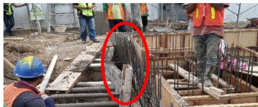
Gambar 2. kerusakan pada dinding Ground Water Tank (GWT)
