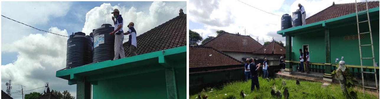
Gambar 3. Instalasi air bersih dan tower tank M-Point 1200 Liter
